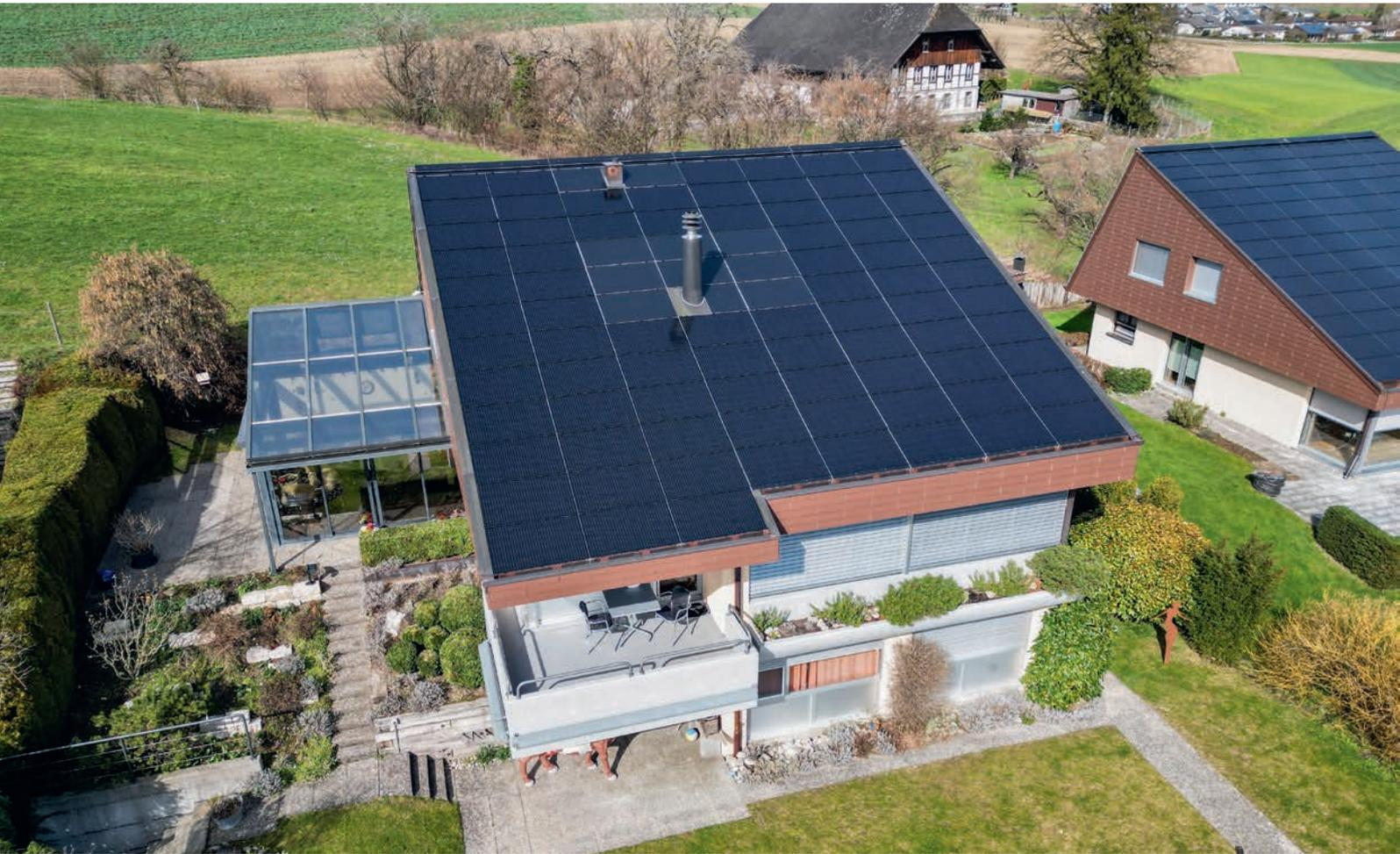
Dieses Einfamilienhaus steht in einem Quartier mit zahlreichen Plusenergiebauten. Das Gebäude wurde umfassend modernisiert, unter anderem mit einer Dämmung der Schrägdächer, Giebelwände und Kniestöcke. Die Photovoltaik-Anlage liefert 15 kWp.
