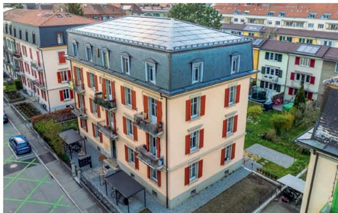
Das Mansardendach dieses Wohnhauses wurde modernisiert und gedämmt. Das neue Solardach mit teilweise massgefertigten Modulen liefert 21 kWp.
