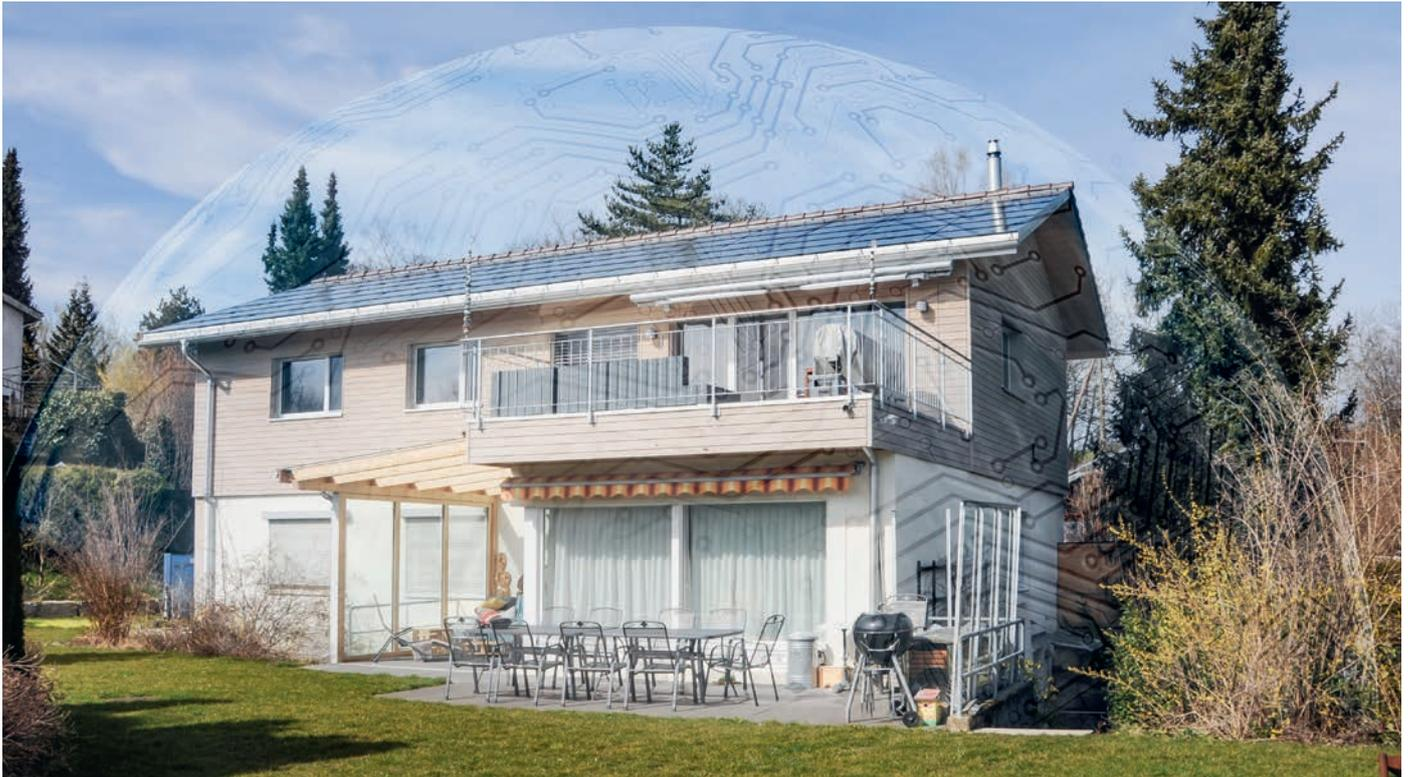
Dieses ältere Gebäude erhielt dank einer Aufstockung eine zweite Wohnung und wurde zum Plusenergiebau. Wände und Kellerdecken wurden gedämmt und ein Solardach installiert, welches auch Strom für zwei Elektrofahrzeuge liefert.
